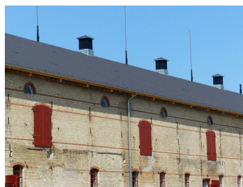
Billede 10. På billedet ses den renoverede langfacade med lemmene, som oprindeligt blev anvendt til indlæsning af stråfoder på det store loftsrum. På rygningen ses rekonstruktionen af de oprindelige aftrækskorstene (tårnspir) og lynafledere.
