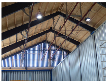
Billede 9. Her ses den nye rammekonstruktion med træåse på tværs og træbeklædning som underlag for pap, som er den afsluttende tagbelægning. Bemærk gavlbeklædningen af brædder som er opsat med en lille afstand for ventilering af kornladen.
