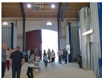
Billede 7. Billedet viser den nye port fremstillet efter den oprindelige, som var todelt med begge døre sidehængte. Lige til højre for porten er der udvendigt bygget et påslag/korngrav til modtagelse af korn og frø. Den indvendige centrale plads er dimensioneret for lastvogne til udtransport.
