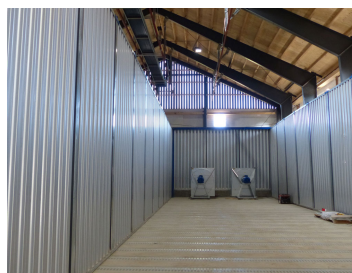
Billede 8. Billedet viser en tom plansilo, som nu i oktober 2013 er fyldt med korn og frø. Gulvet er opbygget af nedgravede kanaler til transport af henholdsvis kold og varm luft. Luften presses op gennem riste (gælleplader) i gulvfladen, som ligger præcist i gulvfladen, så kornet kan hentes ud fra plansiloen med gummiged.
